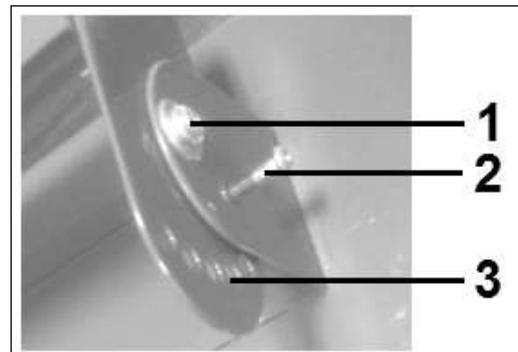
kan nu placeras i fem (värmeeenhets små hål över konsolens små hål (3)). Mittenläget är horisontellt ut i rummet. De två uppåtriktade lägena används bara i exceptionella fall och kräver större avstånd till taket (1 m). Slutligen har värmaren två lägen som är nedåtriktade. Det här är den normala justeringen. Montera värmeeheten i rätt höjd genom att vrida de två små skruvarna (2) genom de dubbla hålen.
